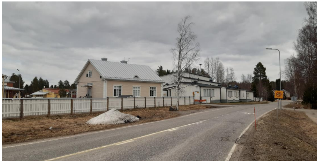
Kuva 6. Asemakylän raitti, jossa näkyvät v. 1937 (D) ja 1982 (B) valmistuneet koulurakennukset.
